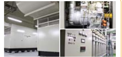
▲(左・右上)自家発電装置 (右下)濾過装置
